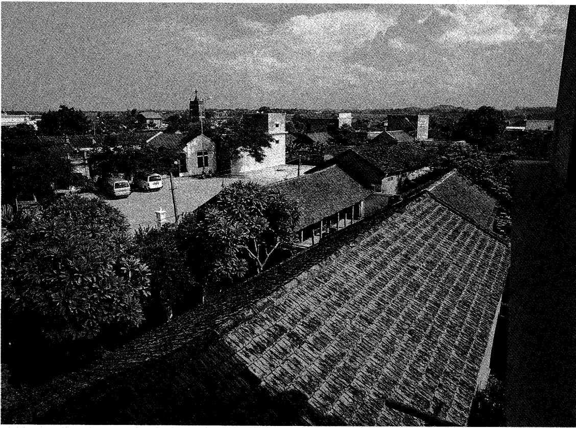
モンフー集落全景 デイン前広場から教会方向を見る
