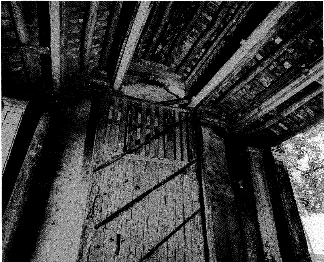
12 モンフー集落 門 内部
