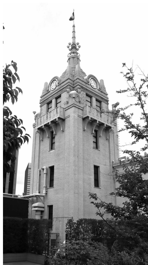
図 49 日本橋三越本店・屋上の塔屋 (現在)
