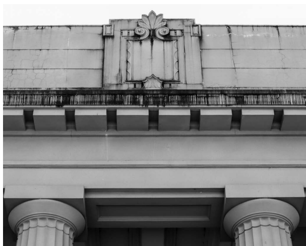
図20 旧枢密院庁舎・正面車寄せ見上げ
