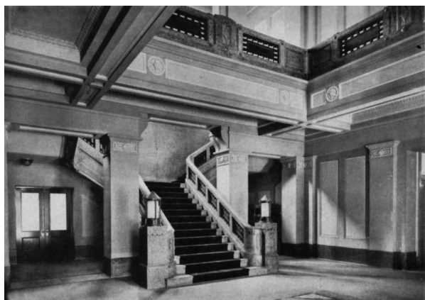
図25 旧枢密院庁舎・広間（創建時）
