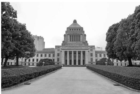
図1 国会議事堂の正面東側の外観(正門前から撮影)
