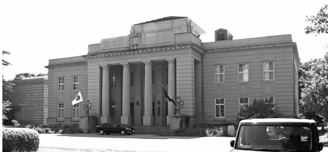
図17 旧枢密院庁舎正面側（現在）
