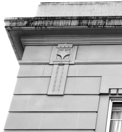
図 22 旧枢密院庁舎・正面側端部の飾り
