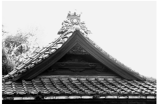
図3 宇佐神社拝殿 屋根詳細 (平成27年8月撮影)
