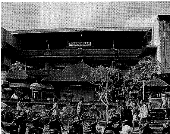
写真-44 デンパサール、4階建ての市場施設
