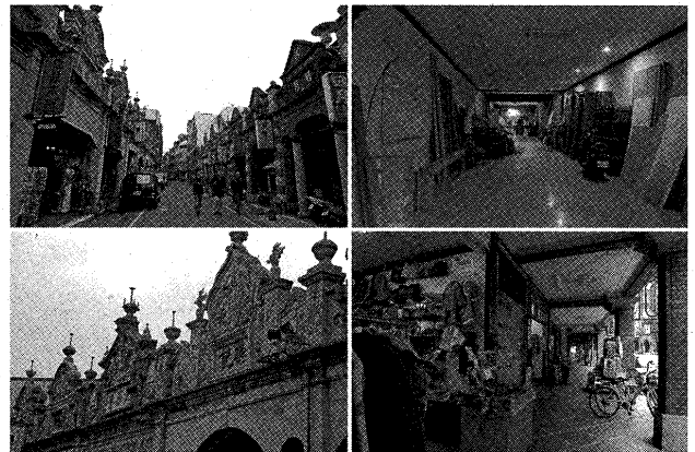
写真 138: 現在の和平路。電線は地下に埋設された。 写真 139: 現在は作業場となっている街屋内部。 写真 140: ファサード上部の装飾 写真 141: 亭仔脚内。商品が張りだし、自転車が停められている。
