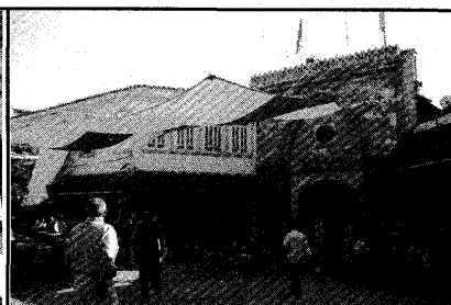
ベヤズィット広場に面するグランド・バザールの門。営業時間以外は施錠される。
