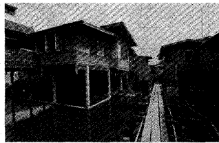
写真73 高床式の住居。杭を打って支持している。
