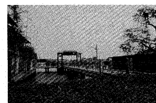
写真7 建安宮へと続くコンクリート製の遊歩道。
