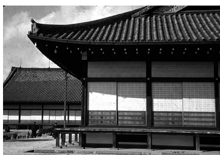
大広間（手前）・小広間（左奥）の南面（西面も同仕様）改造 寛永3年（1626）障子は後補 一部の柱も後補
