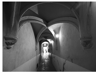
写真5 トラブールの内部。入口から通路が続く。(No. 10)
