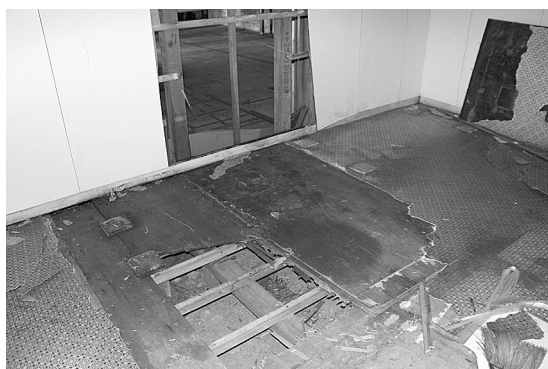
図 40 番付⑥にある独立基礎 (図 15 に点で表示)
