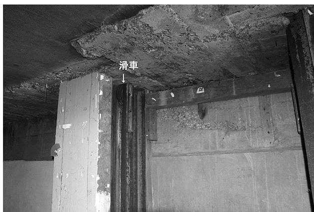
図 42 旧監的壕に標的を上げ下げした鉄柱と滑車が残る。
