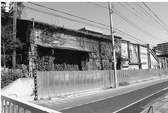
図6 旧射撃場南側面の西端部分
