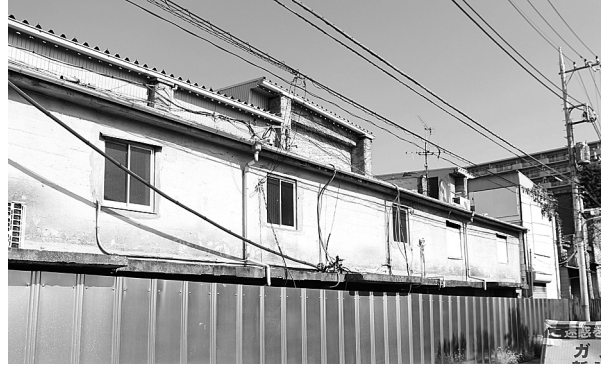
図8 旧射撃場南側面の下屋部分
