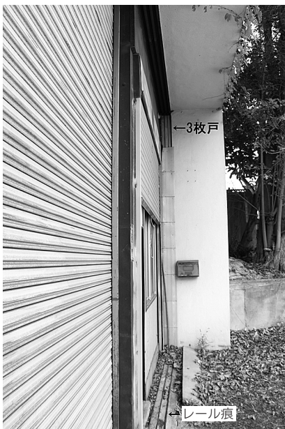
図35 旧射撃場東面（番付㉑）に引き込まれた3枚戸とレール痕
