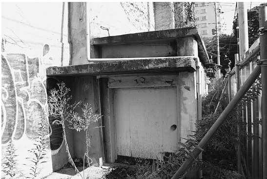
図7 旧射撃場南側面の張り出し部分（地下室に通じる）
