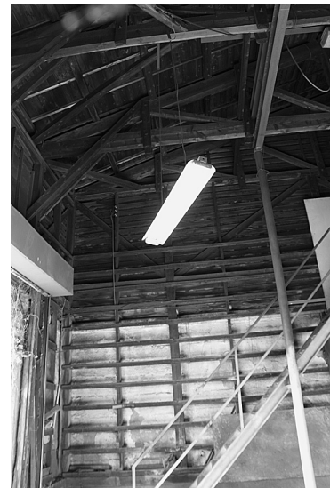
図 28 旧射撃場西面の室内側を見る。
