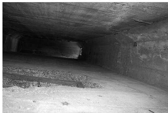
図 43 旧監的壕の北側に付く吹き抜けを見上げる (換気用)。
