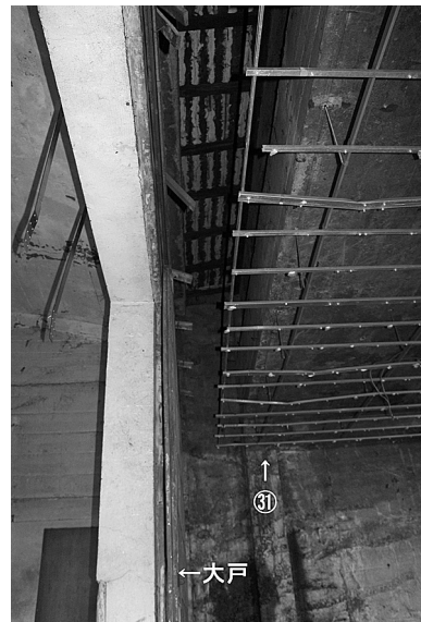
図 48 番付㉑の見上げ（大戸との間に隙間があり、その上は木造屋根で覆っている）
