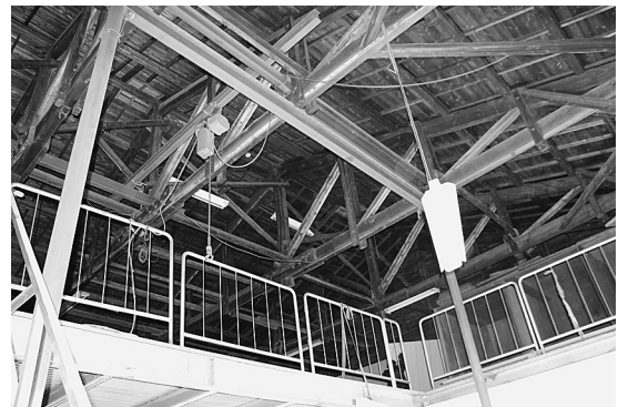
図10 旧射撃場の西端部の小屋組
