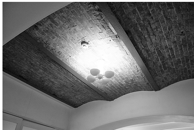
図8 法務省旧本館に残る防火床
