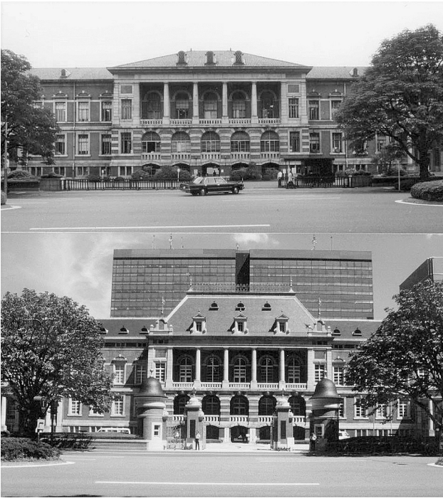
図1 法務省旧本館 (上) 改修工事前 (下) 改修工事後
