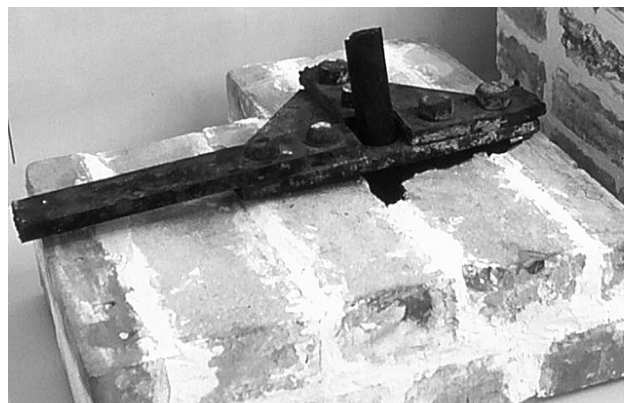
図7 碇聯鉄構法（法務省旧本館建築史料展示室所蔵）
