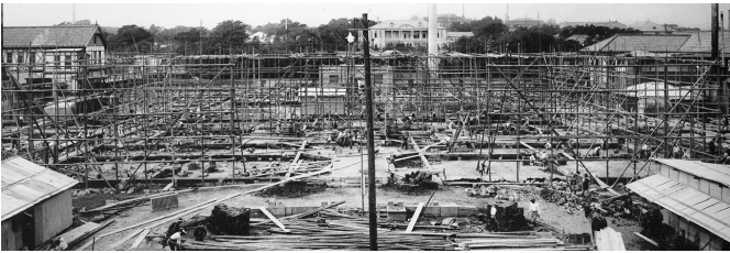
図7 工事中の写真,「中央部」(10月5日)
