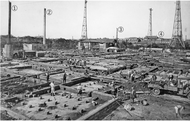
図6 工事中の写真,「全景」(10月1日)
