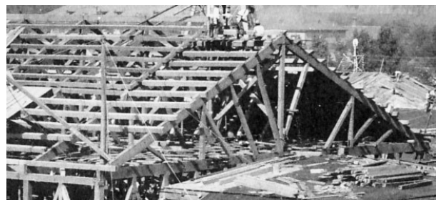
図28 同・工事中の衆議院議場の小屋組(10月21日撮影)
