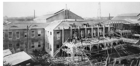
図15 工事中の写真,「衆議院前部」(11月19日)
