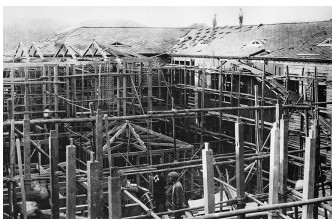
図10 工事中の写真,「衆議院後部」(10月26日)
