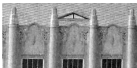
図41 中央玄関上部の妻壁（図2の拡大）
