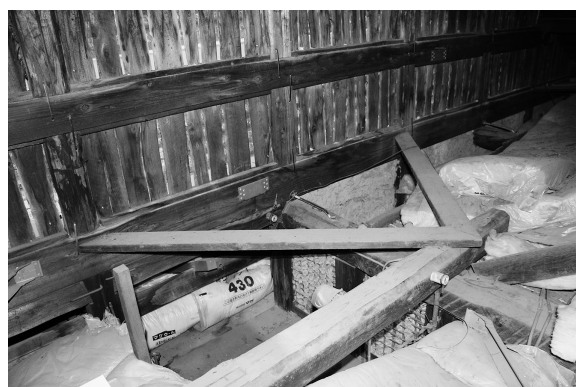
図 31 屋根裏の火打 (小幅板)
