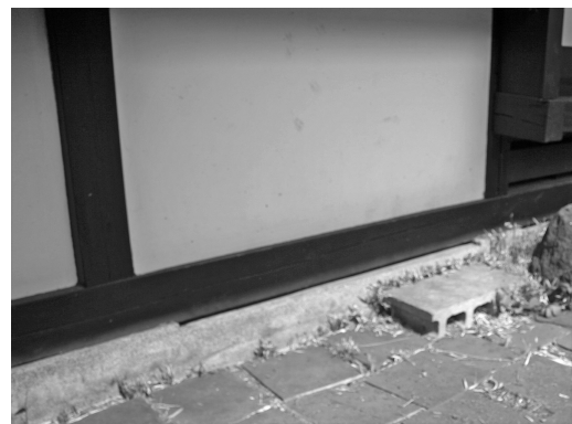
図 14 南側のテラス廻りの基礎と土台の間に換気口がある。
